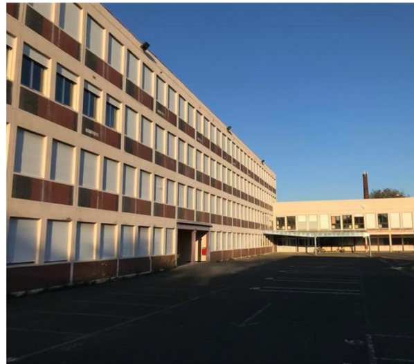
Installée de 2007 à 2020 dans des locaux publics, au Pile, l'association AIR est désormais implantée dans la Cité entreprenante, dans l'ancien collège Samain.
