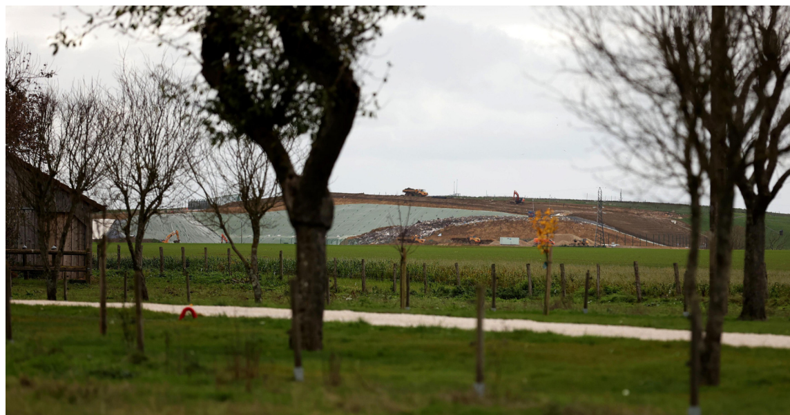
Alors que le stockage de déchets dangereux est peu visible depuis les environs, ce n'est pas le cas du stockage de déchets non dangereux à Drambon. PHOTO LUDOVIC MAILLARD
